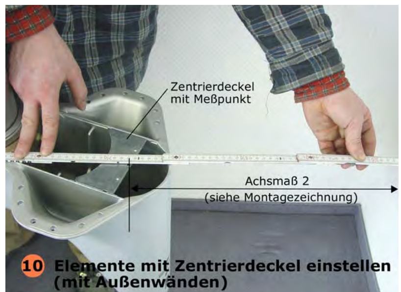
9 Elemente mit Zentrierdeckel einstellen (mit Außenwänden)
