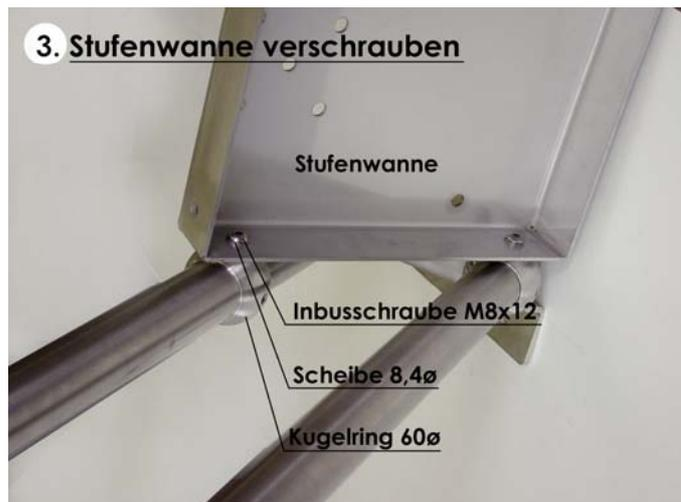
Bei einer größeren Stufenzahl (ab ca. 10 Stufen) sind Stufenwannen mit seitlichen Verstärkungsblechen in der Lieferung enthalten (Abb. 4). Diese werden in Treppenmitte mit 2 zusätzlichen Kugelringen an den Holmrohren befestigt (entsprechend mehr Kugelringe auf Holme auffädeln).
